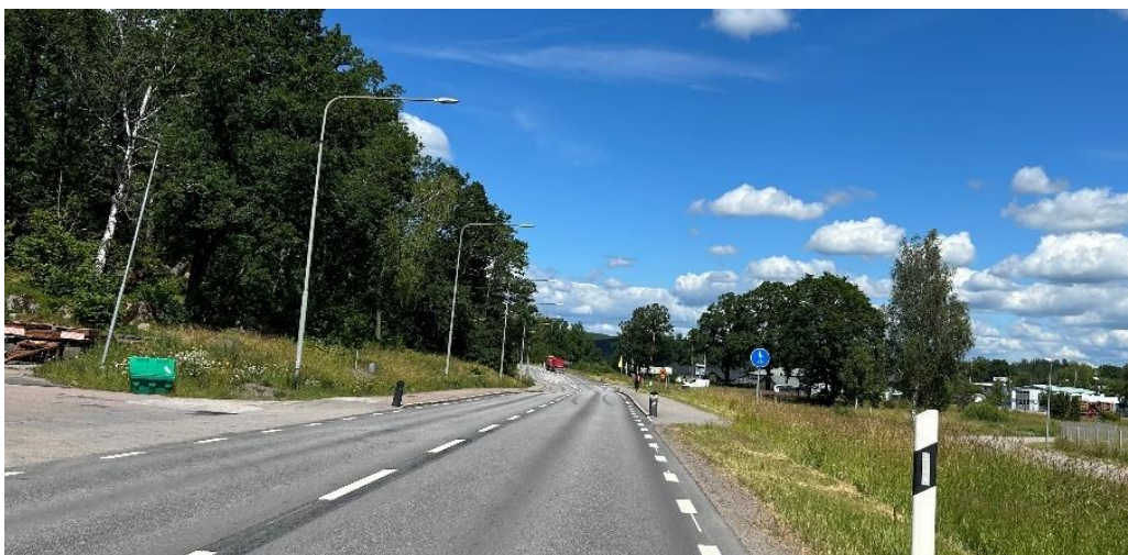
Figur 10 Passagen för GC-trafik över Storgatan sedd söderifrån.
