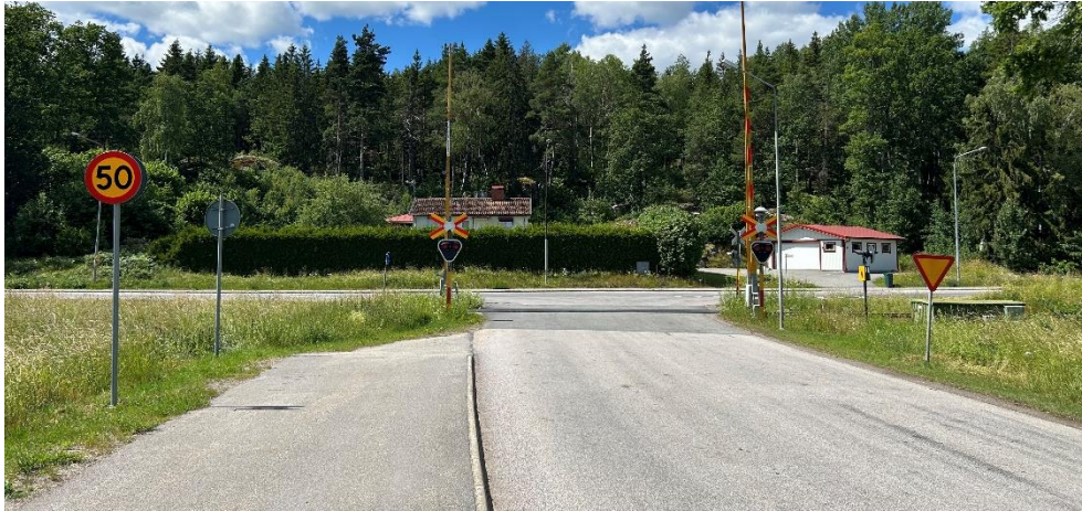
Figur 13 Cykelbana i början på Karlebyvägen, direkt efter järnvägs korsningen (vy från väst)
