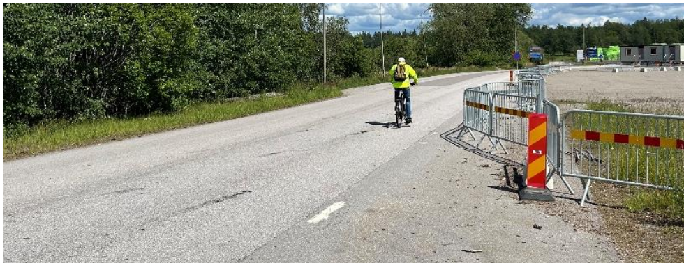
Figur 22 Avspärning närmast infart till sågen (vy västerifrån, mot infarten).
