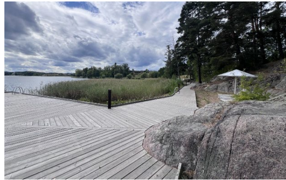
Figur 4. Befintlig boardwalk kan förlängas söderut.
