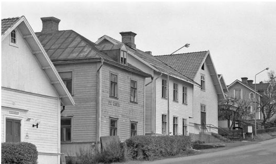
Figur 6. Fotografi längs Grönedegatan sett uppåt. De tre mittersta byggnaderna är idag rivna och ersatta med befintlig kyrkobyggnad. Foto Göran Johansson
