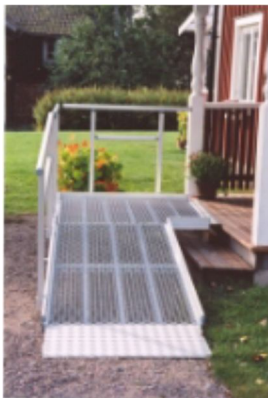
Utvändig entréramp för att komma in med rullstol
