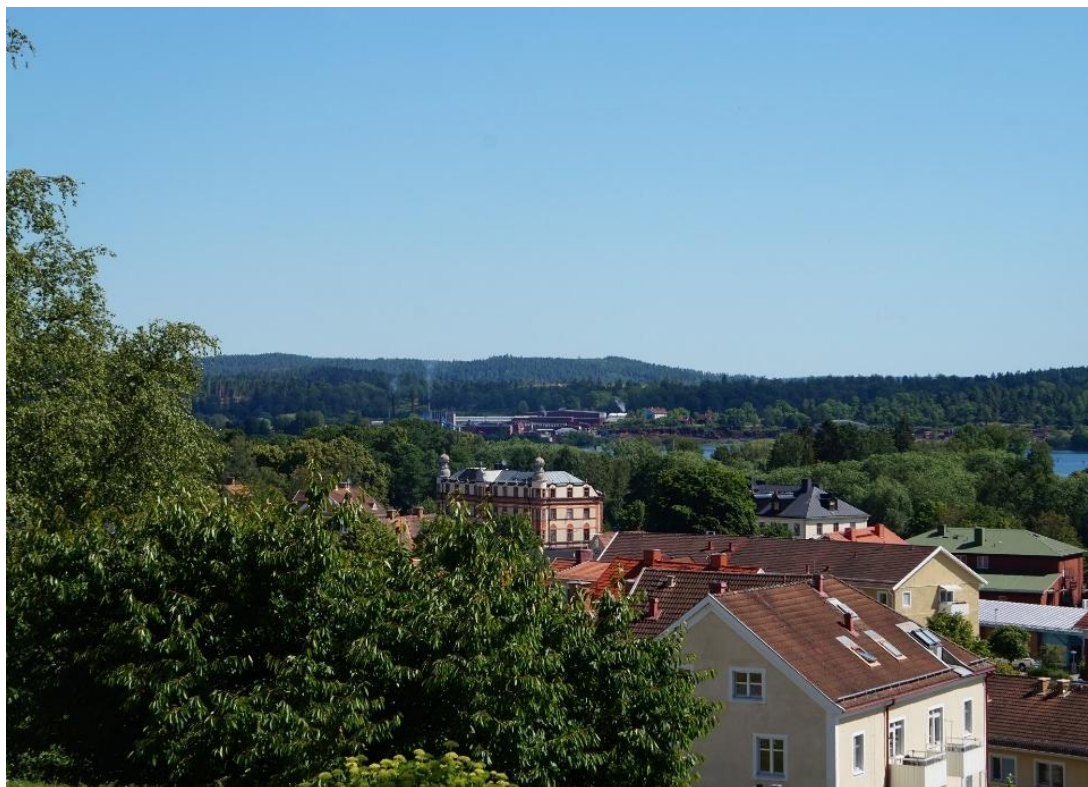
Figur 7. Området sett från centrala Kisa. Befintliga skorstenar och bebyggelse syns tydligt på håll i det kuperade landskapet.
