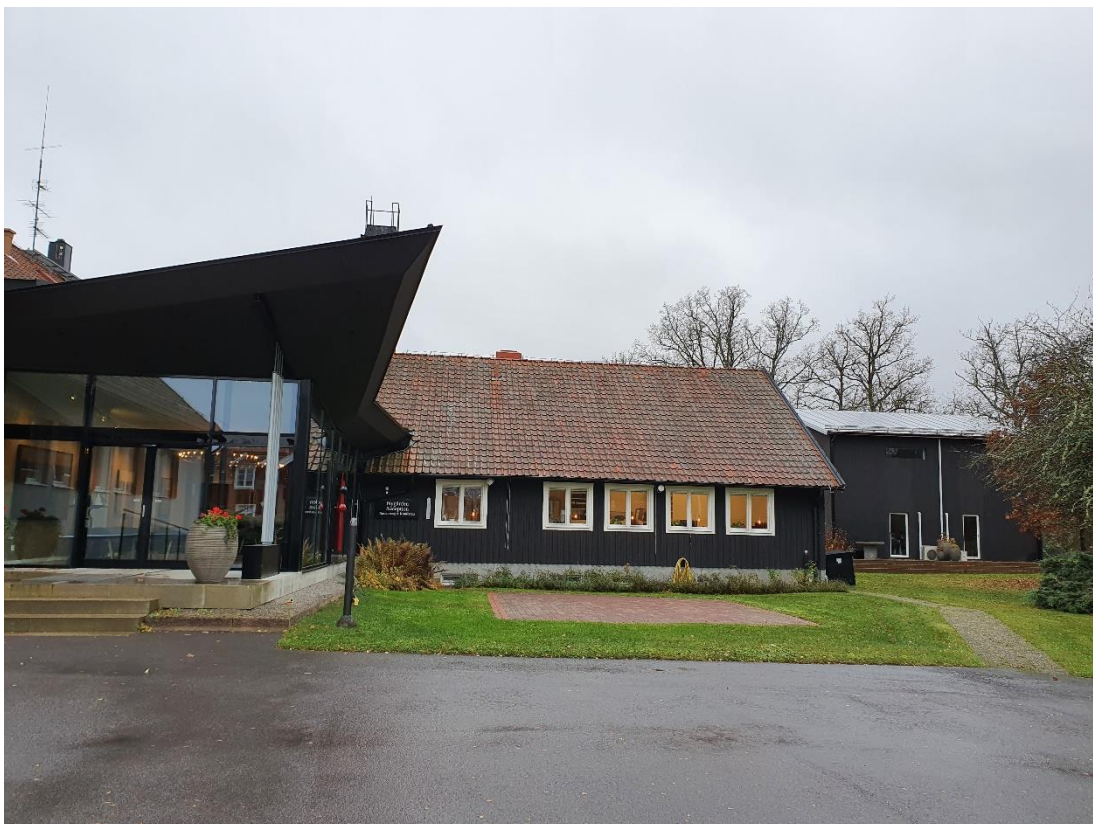
Figur 13. Bild på Nygården, huvudbyggnaden för konferensanläggningen.
