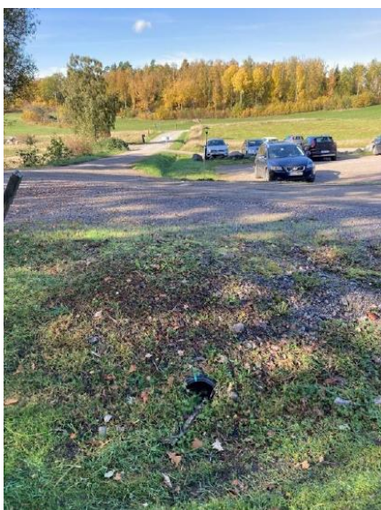
Figur 22. Bild från dagvattenutredning (Geosigma, 2022). Visar gräsdike och en kulvert under befintlig väg vid parkeringen till konferensanläggningen.
