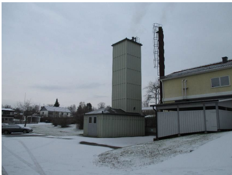
Fjärrvärmecentralen och ett lokalt fjärrvärmenät betjänar idag ett antal bostadsbyggnader samt Rimforsa skola.
