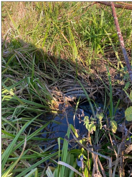
Figur 3-8. Kulverten som leder vatten österut under Kalmarvägen.
