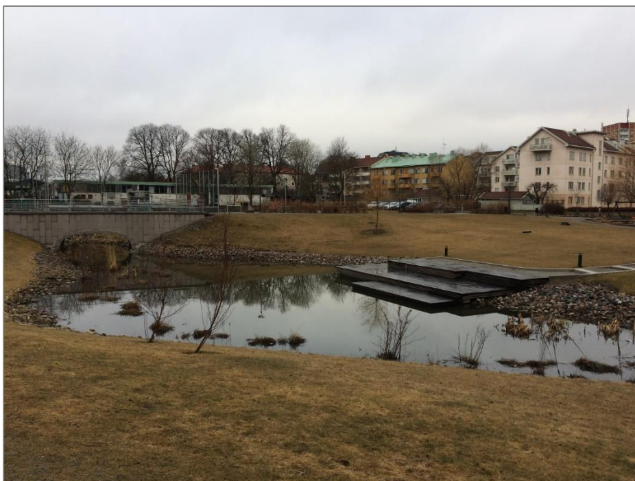
Figur 6-3. Exempelbild av en våt dagvattendamm.
