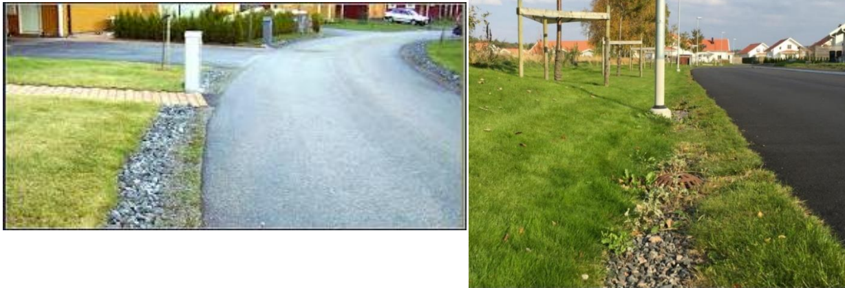
Figur 6-2. Verkliga exempel på makadamdiken. Foto: Sweco.
