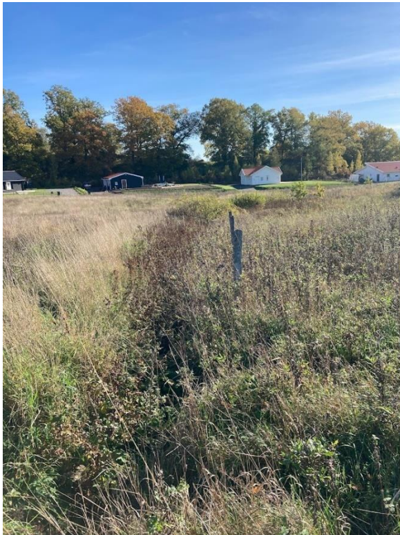
Foto 1. Det befintliga gräsdiket, se mörkare växtlighet i terrängen. Foto tagen med rygg mot Kalmarvägen.
