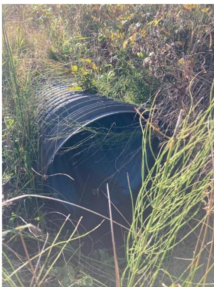
Foto 2. Befintlig dagvattenledning som avleder dagvatten från befintligt dike och vidare söderut.
