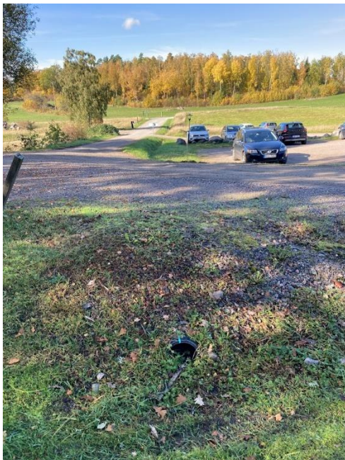
Foto 4. Observerade gräsdiken och kulvert under den befintliga vägen.
